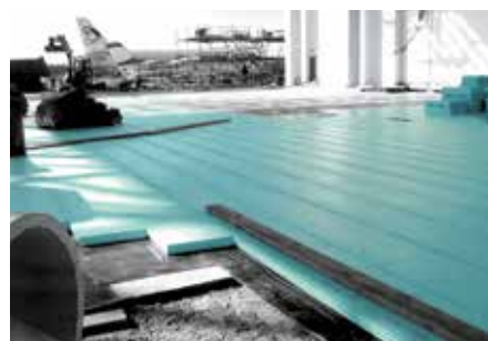
Repülőtéri hangárok hőszigetelése FIBRANxps 700-L .
