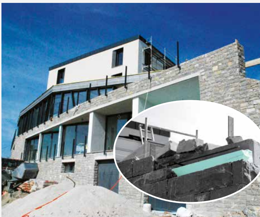
A hotelépület kőborítású homlokzata, melyet FIBRANxps ETICS BT hordozószigeteléssel borítottak, amire speciális eljárással természetes követ ragasztottak.
