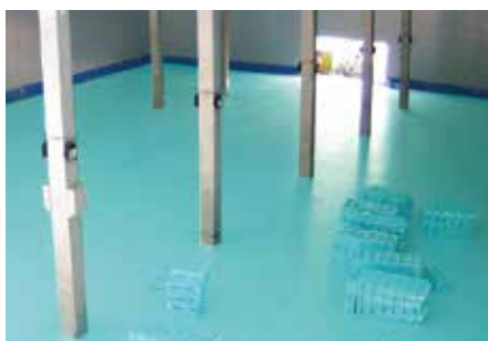
Hűtőházak padlóinak hőszigetelése FIBRANxps 500-L, 700-L .
