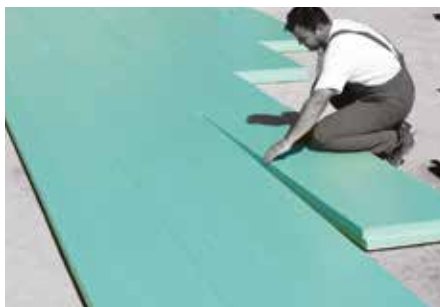
A FIBRANxps 400-L hőszigetelés beépítése a lakóépület padlólapja alá.
