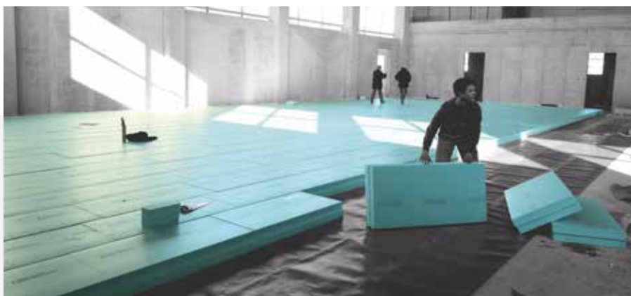
A FIBRANxps 500-L hőszigetelés beépítése a több rendeltetéssel rendelkező objektumok esetében.
