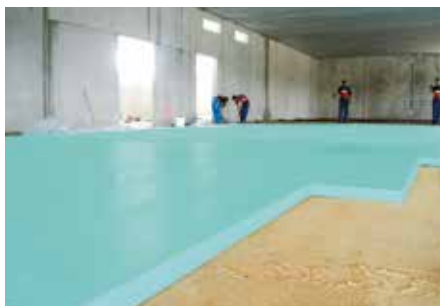
Raktárepületek padlójának hőszigetelése FIBRANxps 300-L-el.
