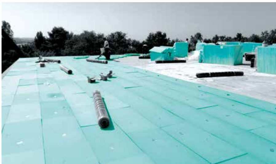
Lapos tető felújítás illetve a tető lejtésszögének emelése FIBRANxps INCLINE lemezek segítségével.
