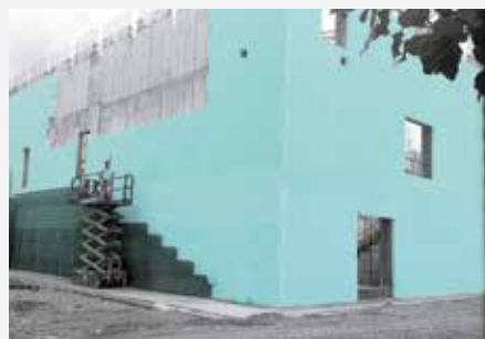
A FIBRANxps MAESTRO szendvics-szigeteléseként; a homlokzat külső részének kidolgozása látható fehér betonnal történik.
