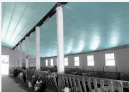
A látható FIBRANxps MAESTRO hőszigetelés védi az istállókat és gazdasági épületeket a nyári felmelegedés és a téli lehűlés ellen.
