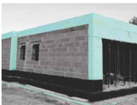
Földrengés-ellenes kötések és áthidalók szigetelése FIBRANxps ETICS-el.
